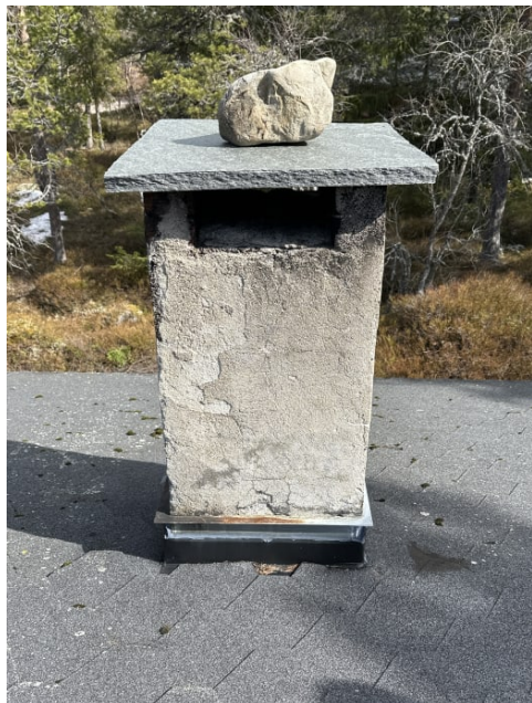
Viser pipe over tak.
