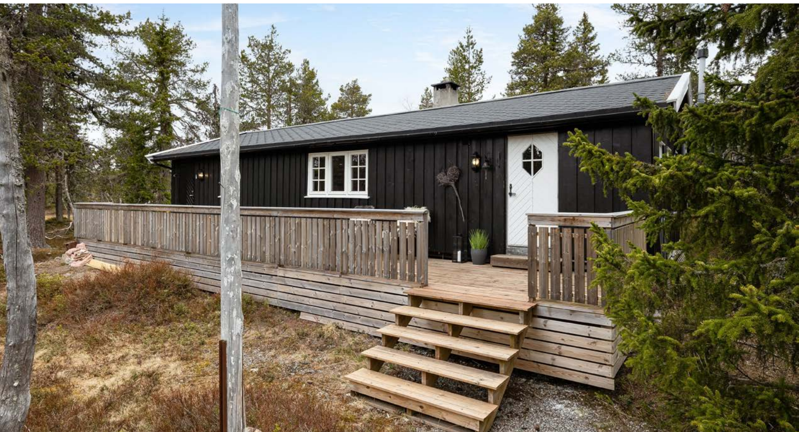
Hele hytta ble beiset utvendig i 2023, har takteking fra 2003 og det ble montert ny utendørs trapp i 2024.
