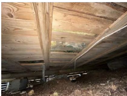
Det registreres åpninger i stubbloft.
