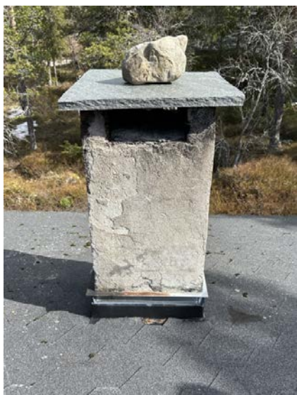
Viser pipe over tak.
