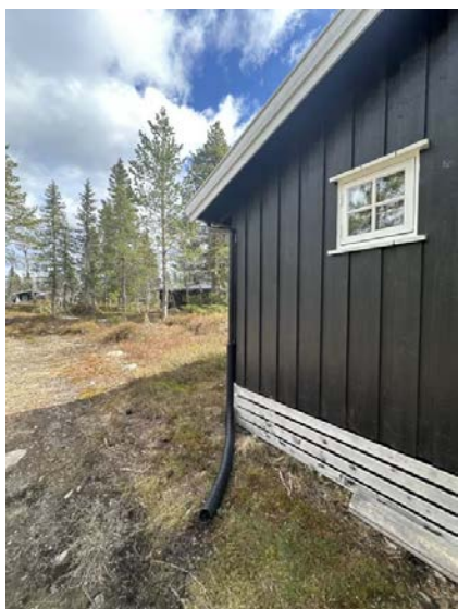
Etablert drenerør på nedløp.
