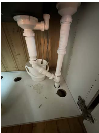
Viser vann og avløpsinnstallasjoner under kum.
