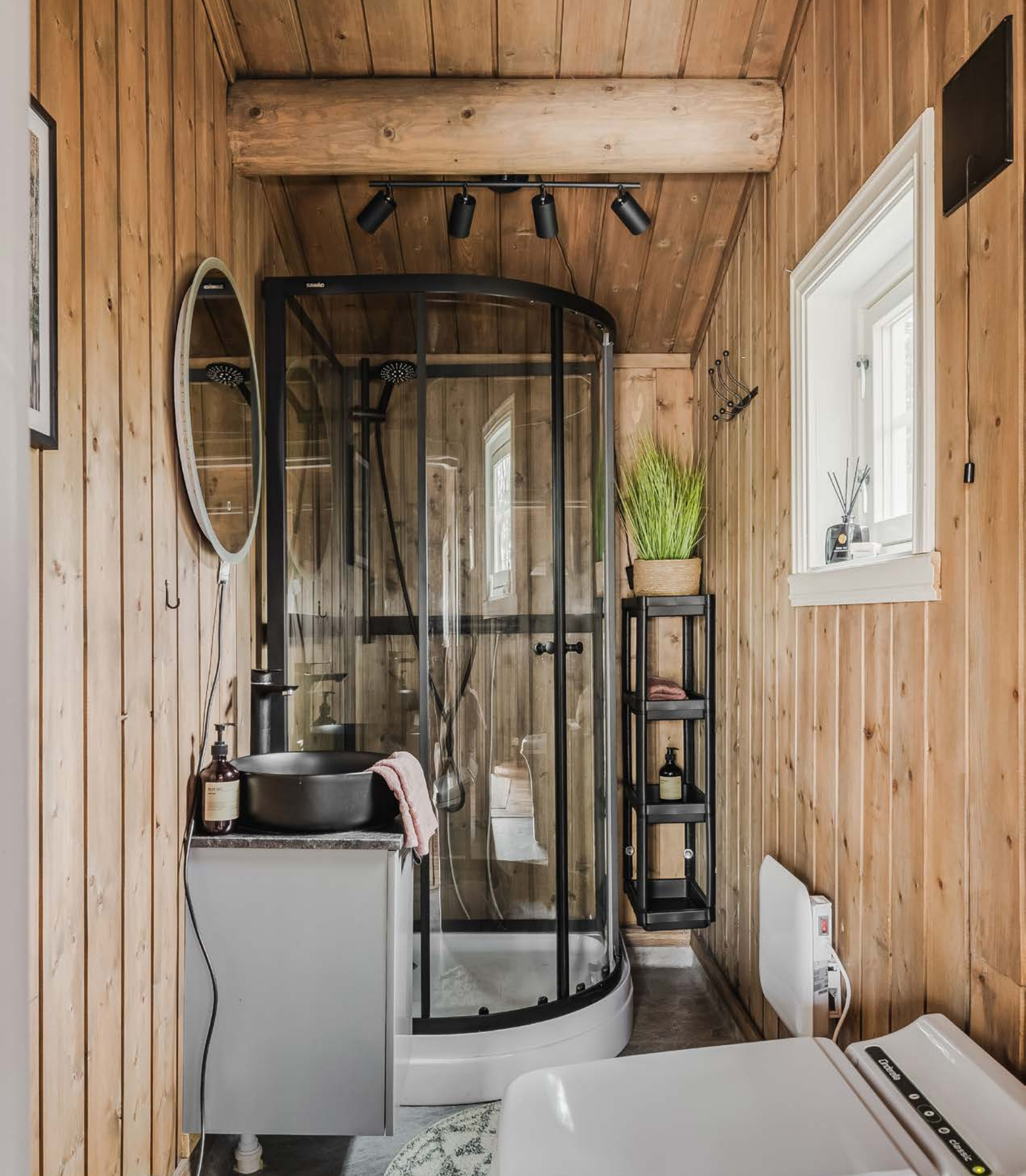
Pent baderom oppgradert i 2022 med våtromsbelegg i vinyl (fra Teppe-Abo) på gulv og våtromsplater (fra Byggmax).
