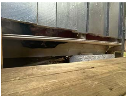
Det registreres åpninger i stubbloft.
