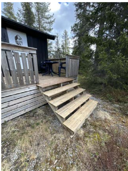
Viser utvendig trapp.
