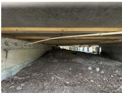
Viser stubbloft under tilbygget del.
