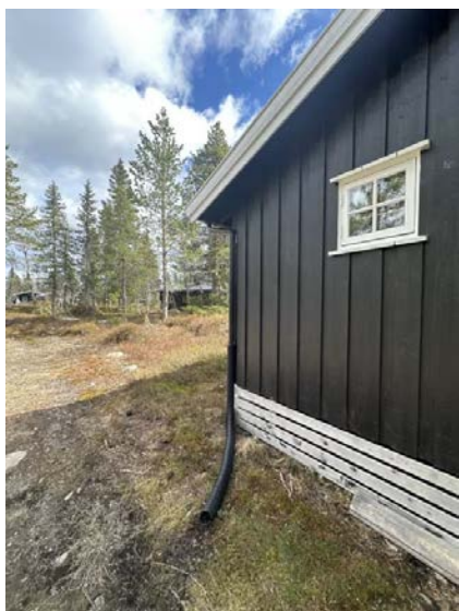
Etablert drenerør på nedløp.
