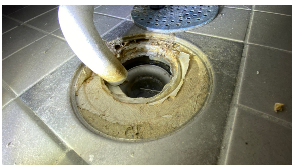
Kontroll av sluk under dusjkabinett.
