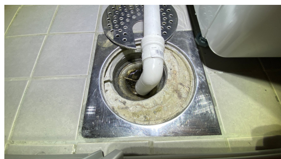
Kontroll av sluk i skyvedørgarderobe.
