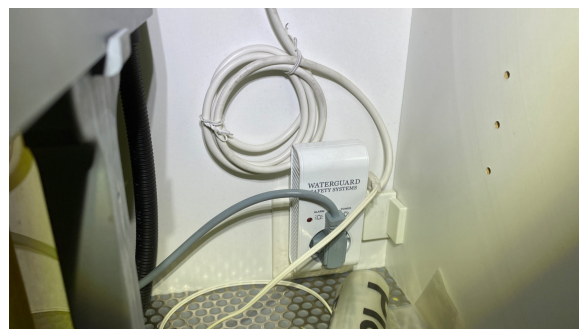
Det er montert lekkasjesikring i skrog under vasken.
