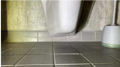
Spalte for synliggjøring av lekkasjevann mangler.
