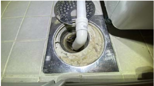
Kontroll av sluk i skyvedørgarderobe.
