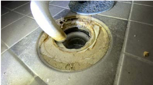
Kontroll av sluk under dusjkabinett.
