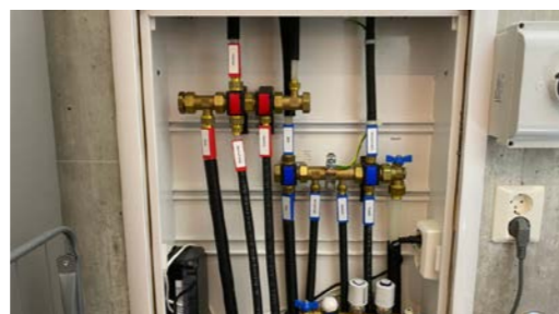
Kontroll av rørfordelerskap.
