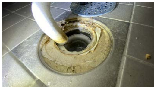
Kontroll av sluk under dusjkabinett.
