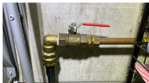
Kontroll av hovedstoppekran.
