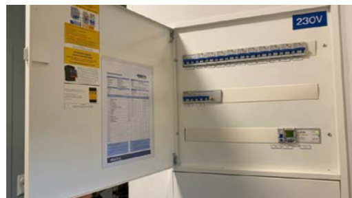
Kontroll av el-skap og kursfortegnelse.
