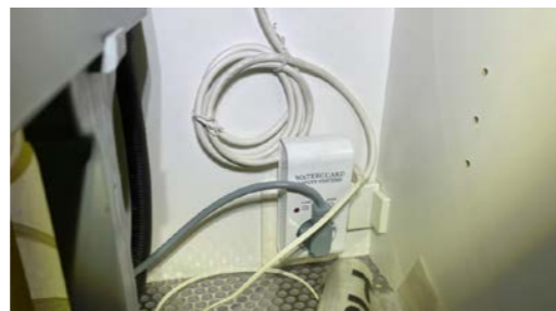
Det er montert lekkasjesikring i skrog under vasken.
