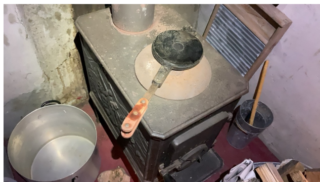
Rust på vedovn
