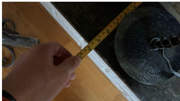
Avstand fra grue til gulv/brennbart material er under 0,8 m
