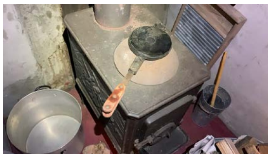
Rust på vedovn
