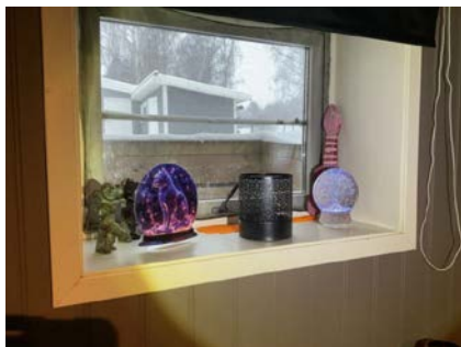
Vindu som skal skiftes ut
