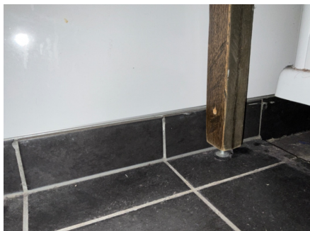
Mangler fug mellom plater og list
