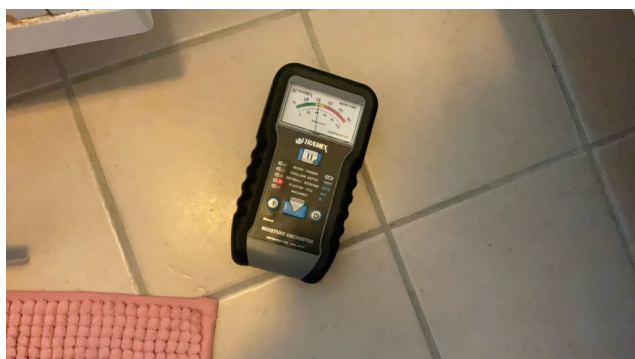
Fuktindikator gir ingen unormale resultater på gulv ved sluk.
