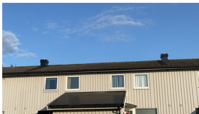
Taktekking av taksteinsplater/Decra.
