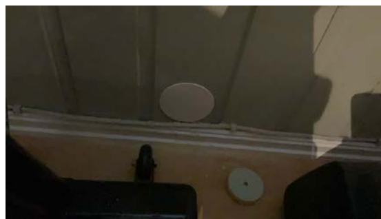
Hull forsvarlig plombert.
