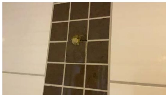
Mosaik øverst på vegg er løs/ buler ut og fosøkt limt.
