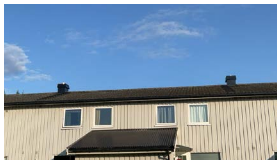
Taktekking av taksteinsplater/Decra.
