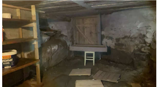
Lav kjeller. Dør ut til overbygget utvendig kjellernedgang.
