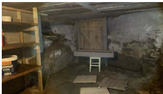
Lav kjeller. Dør ut til overbygget utvendig kjellernedgang.
