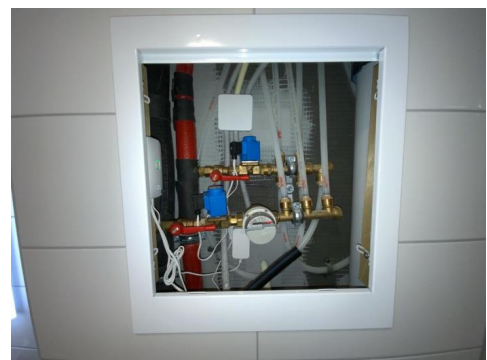
Besiktigelse av røropplegg.
