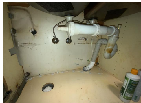
Besiktigelse av røropplegg.
