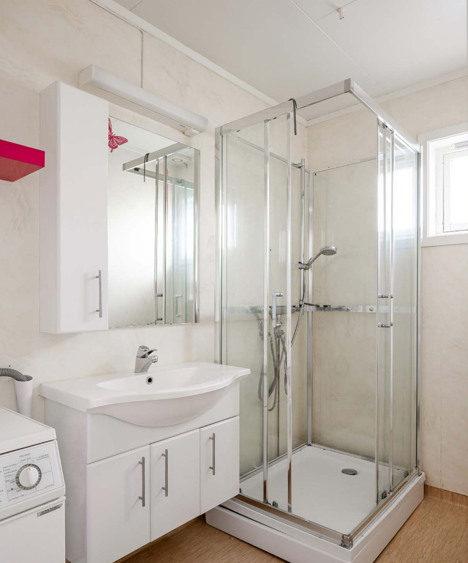
Baderommet i hybeldelen ble pusset opp i ca. 2007. Baderommet har våtromsbelegg på gulv, vinylbelegg på veggene og elektrisk styrt vifte.
