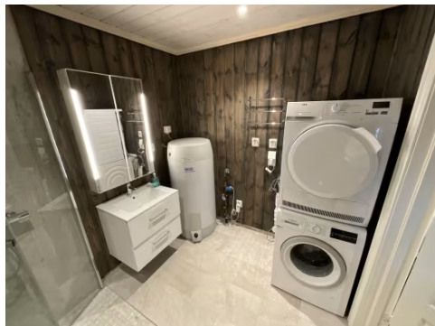
Viser baderomsinnredning, varmtvannsbereder, vaskemaskin og tørketrommel.
