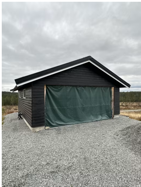
Viser garasje under oppføring.
