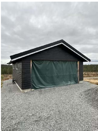
Viser garasje under oppføring.
