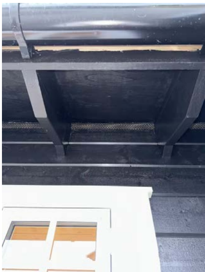
Viser lufting av takkonstruksjonen.
