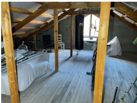
Bilde av uinnredet loft.
