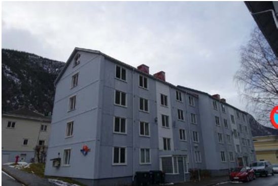
Bilde av fasade med akkumulert vedlikehold.
