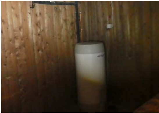
Eksempelbilde ettermontert VVB i kjeller.
