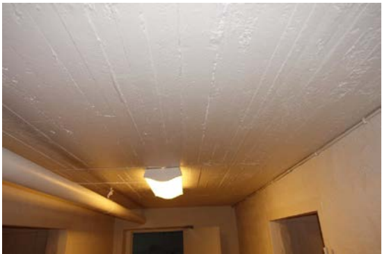
Bilde av etasjeskiller i bygget.
