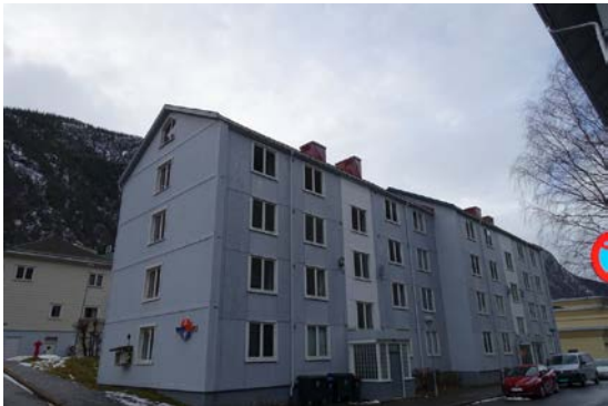
Gavler er påforet 100 mm, ikke isolert og kledd med trekledning.
