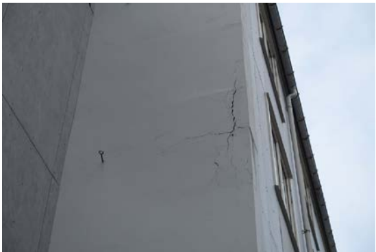
Fasade med betongskader.
