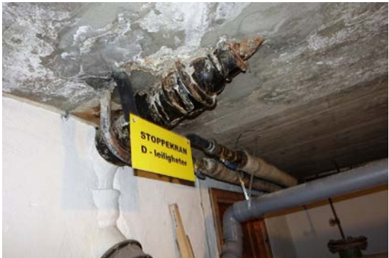
En del av rørene i bygget er eldre opprinnelige rør.
