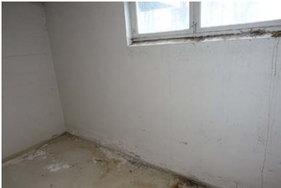
Ingen tegn til nedsatt funksjon på bærende betongvegg.
