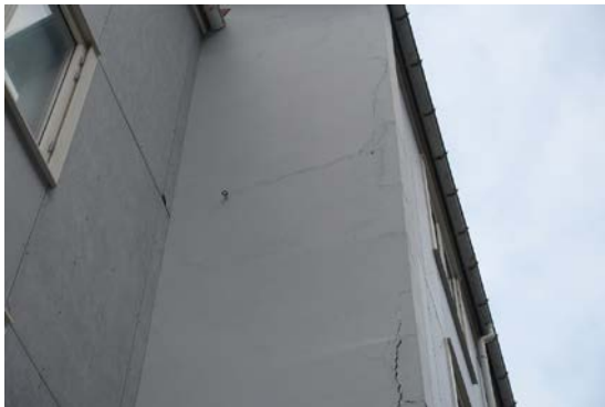
Fasade med betongskader.
