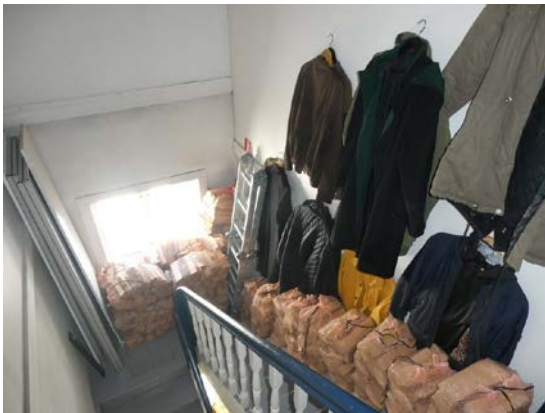
Eksempelbilde på uønsket lagring da rømningsvei blir blokkert.
