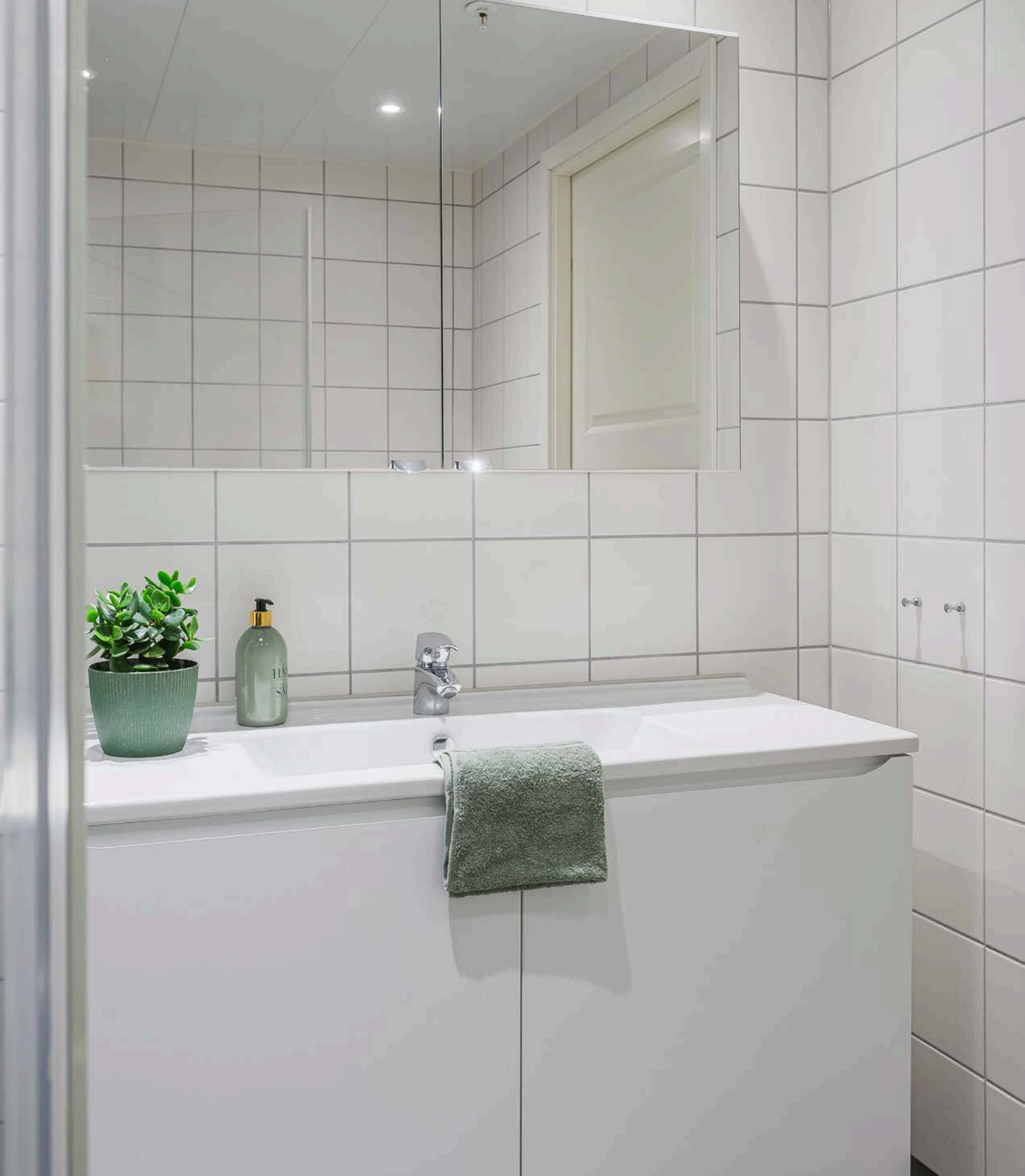
Badet varmes opp med vannbåren gulvvarme.
