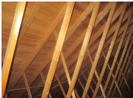
Deler av tilbygget del over stue.
