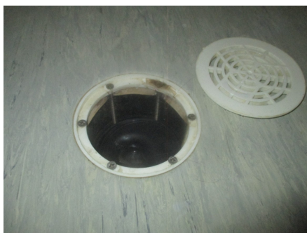
Hulltaking i fra soverommet
