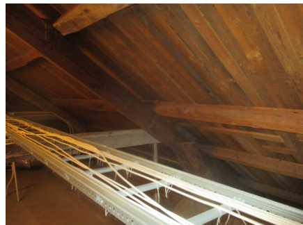
Åsetak med sperrebukker over opprinnelig del.
