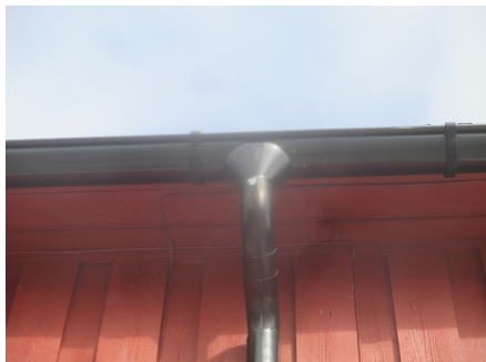
Deler av takrenner.
