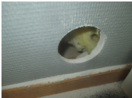
Hulltaking i fra soverommet
