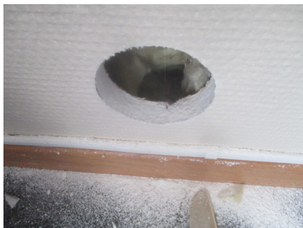
Hulltaking i fra soverommet
