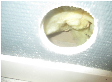
Hulltaking i fra soverommet
