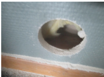
Hulltaking i fra rom 203.
