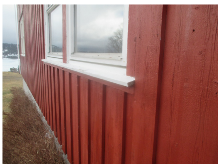
Deler av kledningen med tilhørende belistninger
