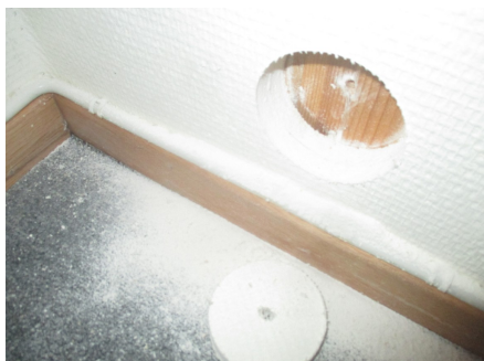
Hulltaking i fra soverommet
