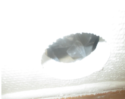
Hulltaking i fra soverommet
