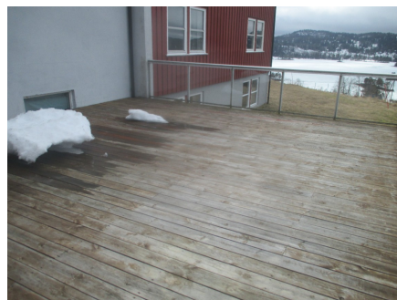
Deler av tørre terrasse ut i fra stue.
