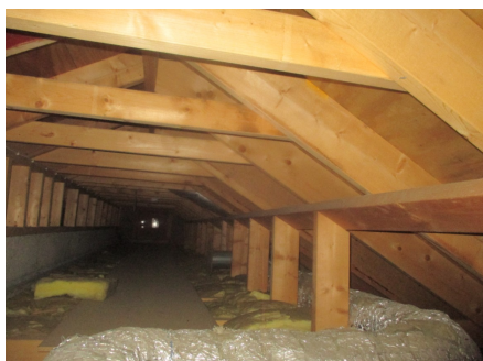
Sperrekonstruksjon over tilbygget fløy
