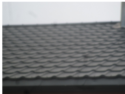
Deler av tekking over tilbygget deler.
