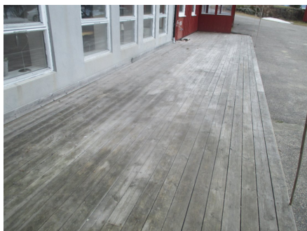
Deler av terrasse på en siden i mot inngangsparti.
