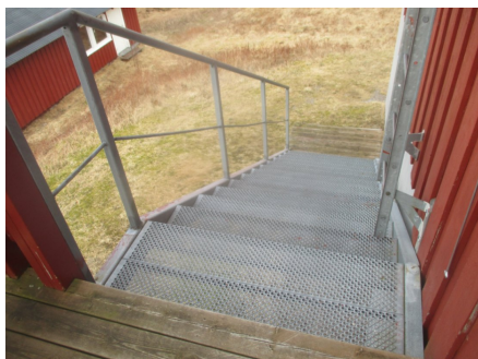
Deler av utvendig ståltrapp.
