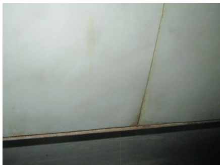
Våtromsplater har swellet.
