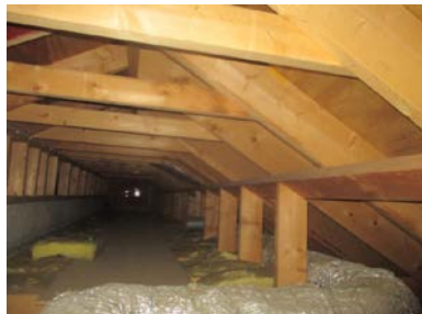
Sperrekonstruksjon over tilbygget fløy
