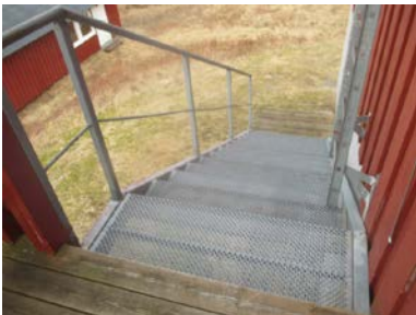
Deler av utvendig ståltrapp.
