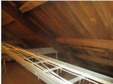
Åsetak med sperrebukker over opprinnelig del.
