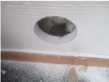
Hulltaking i fra soverommet
