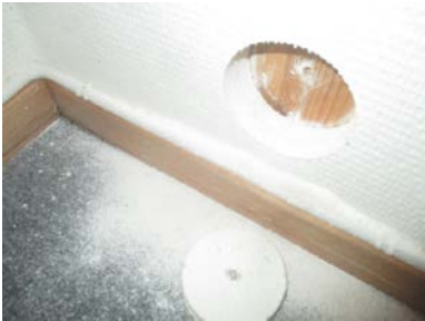
Hulltaking i fra soverommet
