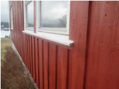
Deler av kledningen med tilhørende belistninger
