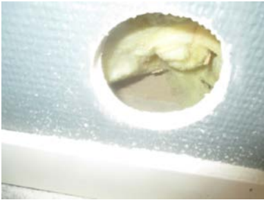
Hulltaking i fra soverommet
