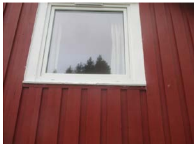
Noen nyere pvc vinduer.
