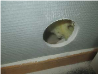
Hulltaking i fra soverommet
