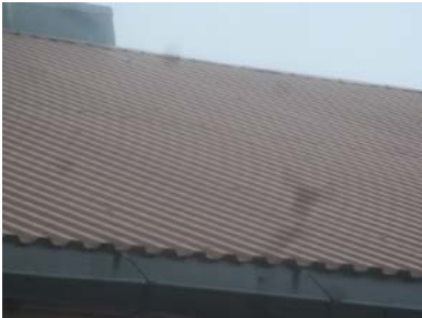
Deler av tekking over eldre del.
