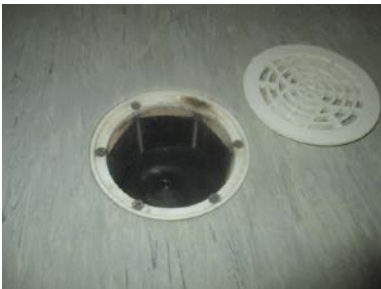
Hulltaking i fra soverommet
