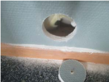
Hulltaking er foretatt i fra soverommet
