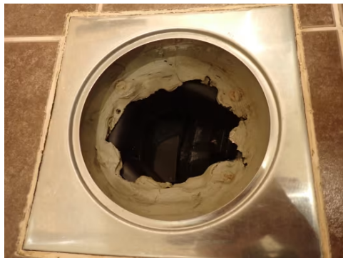
Utførelse av membran i sluk.
