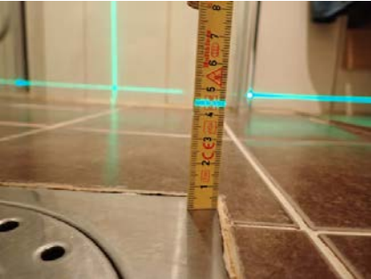
Fallforhold. Referansenivå laser på gulv ved dør = 4 cm.
