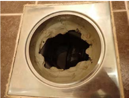
Utførelse av membran i sluk.
