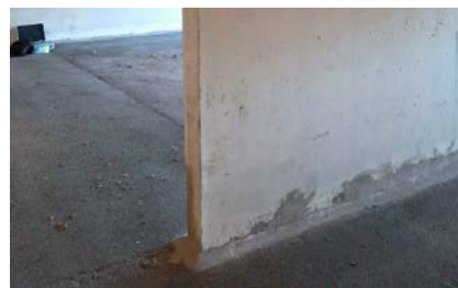
Betongvegg i garasje med hulkil.
