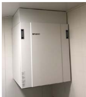
Illustrasjonsbilde av vegghengt ventilasjonsaggregat
