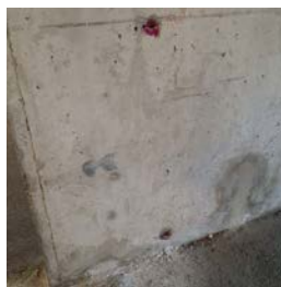
Prøvetaking i betongvegg i garasje
