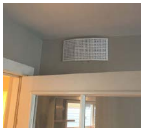
Illustrasjonsbilde av typisk veggmontert ventil for til-luft
