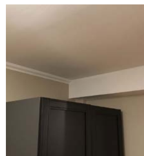
Illustrasjonsbilde av typisk innkassing av ventilasjonskanal
