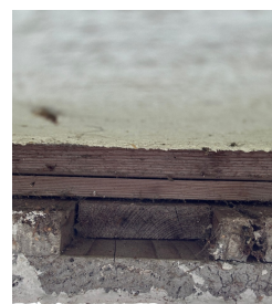
Det er ingen eller liten lufting i nedre kant av kledning mot grunnmur.
