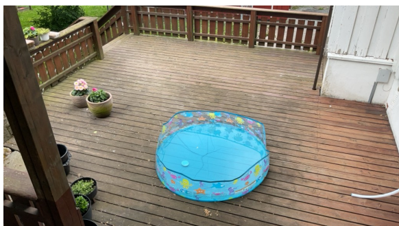
Det er etterslep på vedlikehold av overflater.
