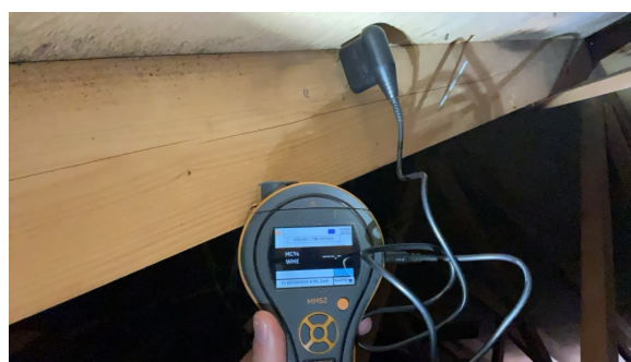
Det ga ikke indikasjon på fukt på befarringsdato
