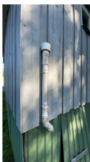
Avløpslufting er plassert på yttervegg ved bad
