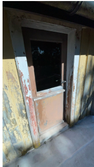
Innadslående dør ut til veranda i 2. etasje.
