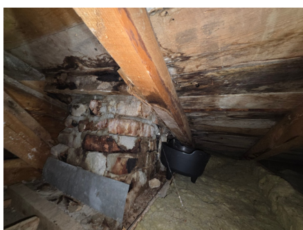
Eldre fuktmerker ved pipe. Ingen fukt på befaringsdagen
