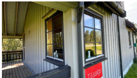
Vindu på stue 2
