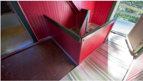
Trapp sett fra loft
