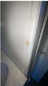
Det er en liten kantskade på høyskap
