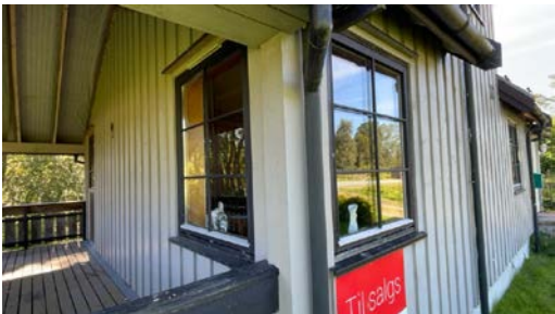
Vindu på stue 2
