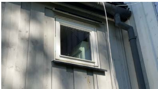
Vindu på bad
