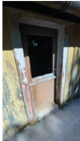
Innadslående dør ut til veranda i 2. etasje.
