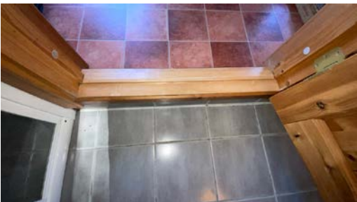
Standard dørterskel uten tilluft
