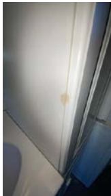
Det er en liten kantskade på høyskap
