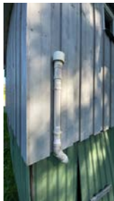
Avløpslufting er plassert på yttervegg ved bad
