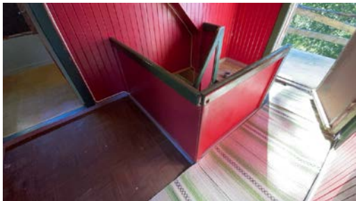
Trapp sett fra loft
