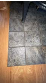
Flis på gulv under ildsted har bom i flis/skifer (Løse flis) og riss/slitte fuger
