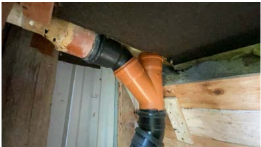
Åpen isolasjon i krypkjeller
