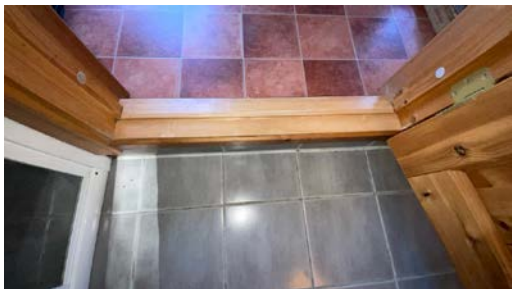
Standard dørterskel uten tilluft
