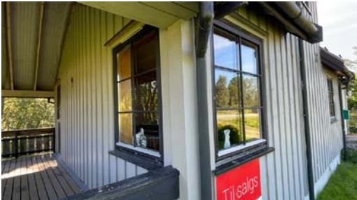
Vindu på stue 2
