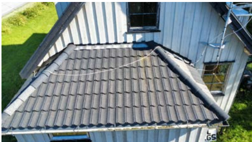
Tak over bad og inngang
