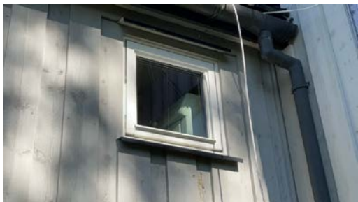
Vindu på bad
