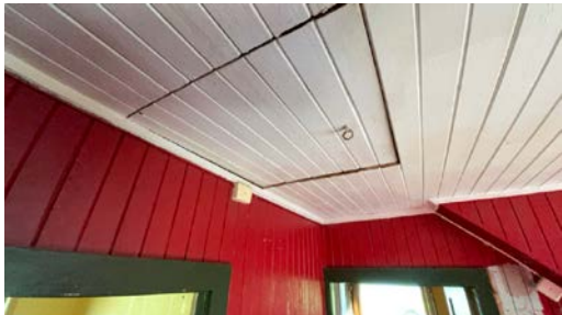
Uisolert loftsluke på gang
