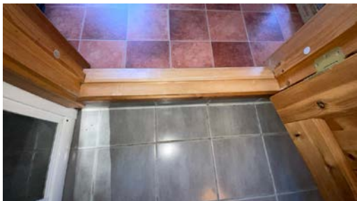
Standard dørterskel uten tilluft
