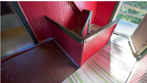
Trapp sett fra loft
