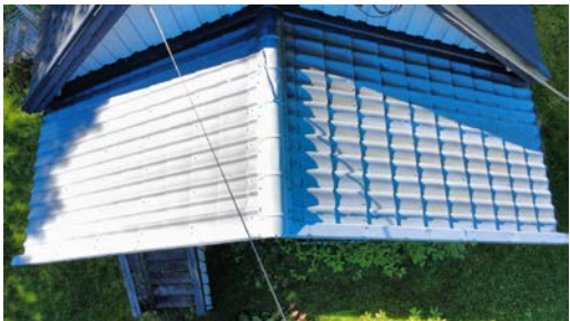
Tak over veranda
