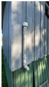
Avløpslufting er plassert på yttervegg ved bad
