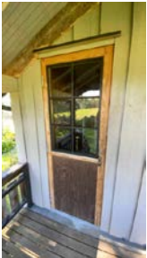
Verandadør med 2-lags glass av ukjent alder
