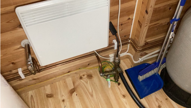
Vannrør ligger mot yttervegg.
