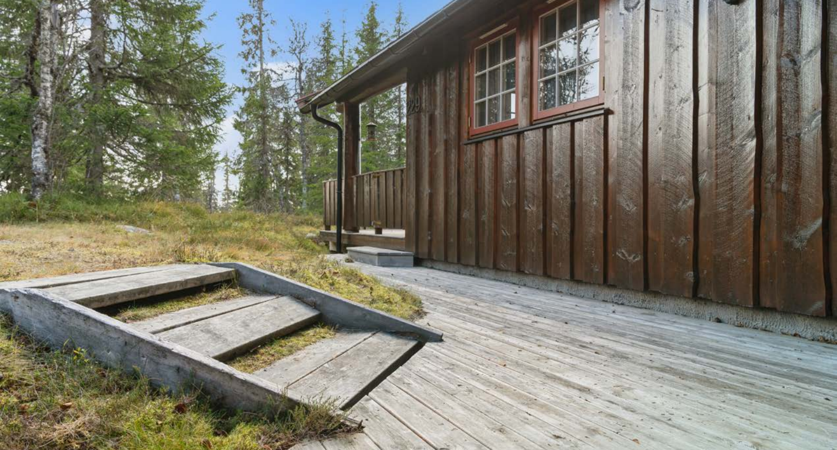
Terrasse ved inngangspartiet.
