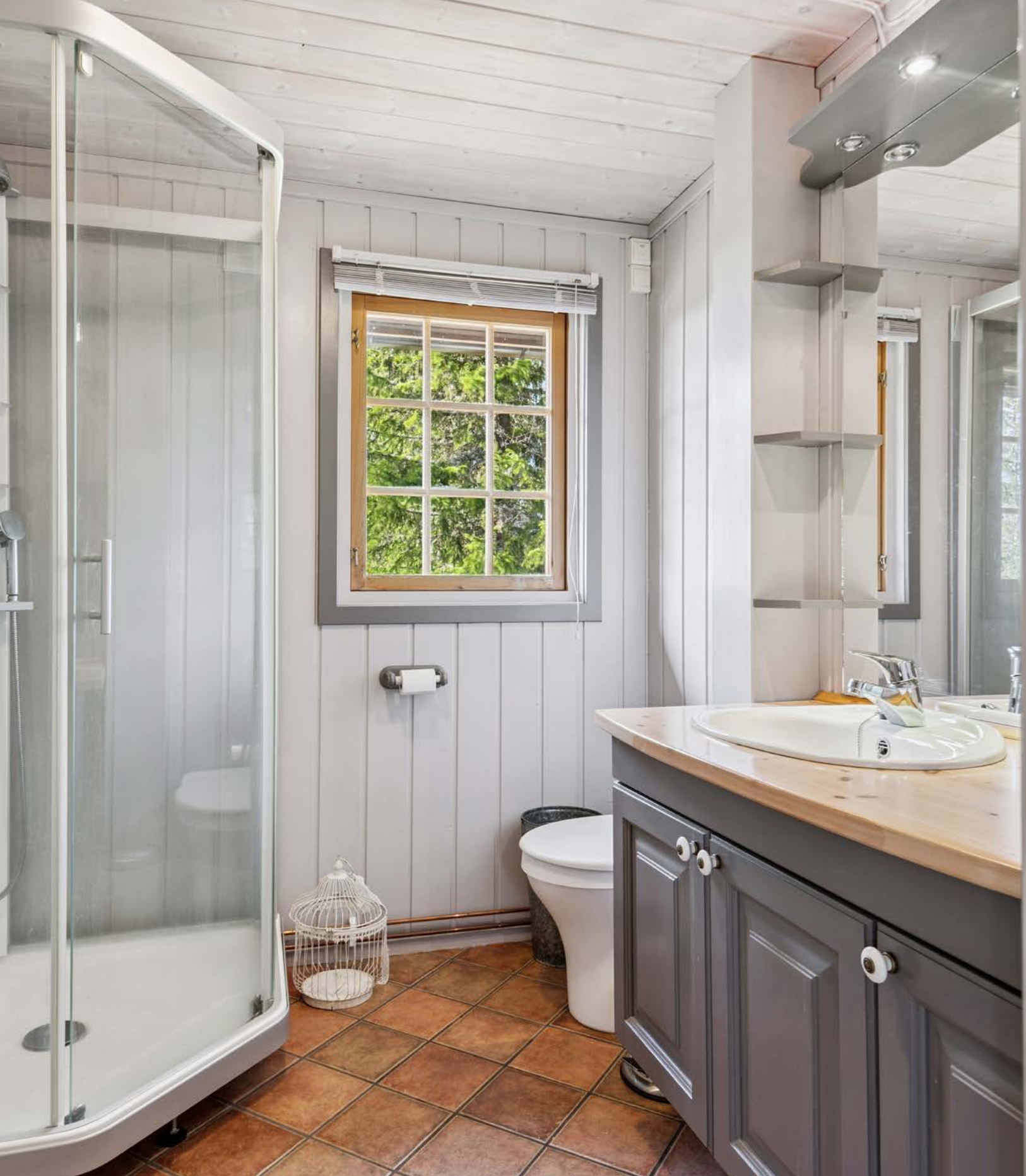
Pent baderom med nedfelt servant i baderomsinnredning, gulvmontert mulltoalett og disjkabinett.
