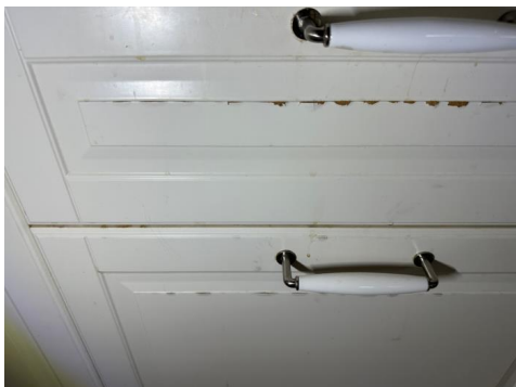
Brukslittasje på en front ved kum
