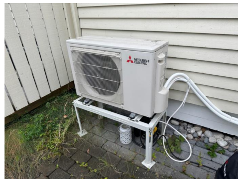
Utedel til varmepumpe
