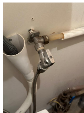
Løsnet kran på vegg til vaskemaskin
