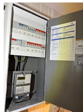
Automatsikringer med skap i trappegang v/bad
