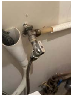
Løstnet kran på vegg til vaskemaskin
