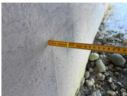
Vegg er presset inn ca. 5-6 cm.
