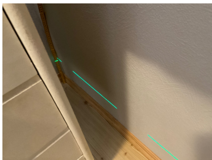
Kontroll i gang i kjeller
