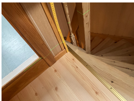
Kontroll i gang m/trapp i loftsetasjen
