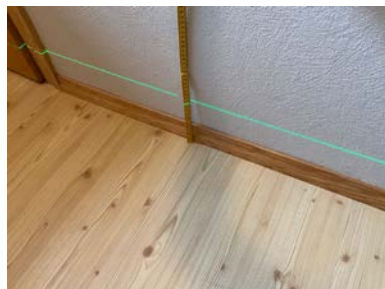
Kontroll i gang i kjeller
