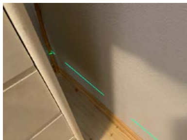
Kontroll i gang i kjeller
