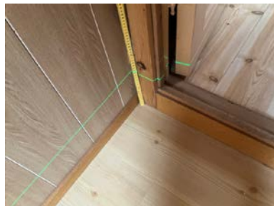
Kontroll i gang m/trapp i loftsetasjen
