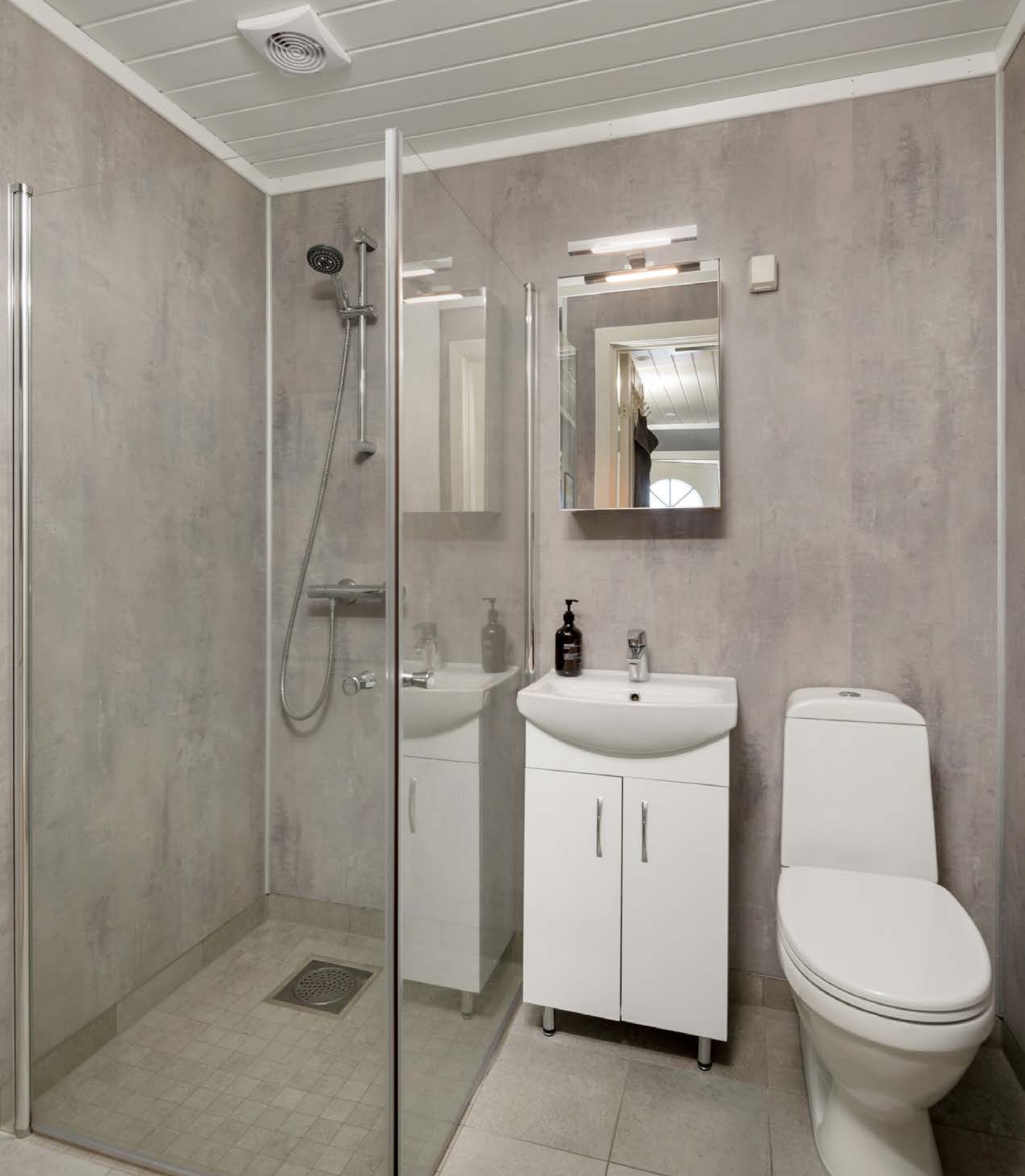
Baderommet som ble pusset opp i 2018 har flislagt gulv med gulvvarme, våtromsplater på veggene, downlights i himlingen og elektrisk fuktstyrt vifte.
