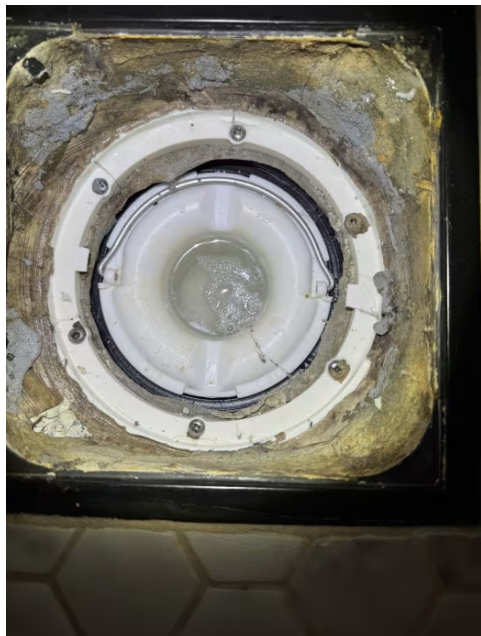
Sluk på bad i 2. etasje.
