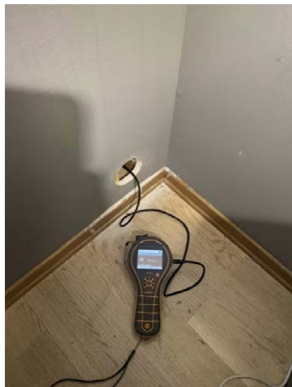
Måler etter fukt med pigg i treverk. Måler under 6 vektprosent, hvilket er OK.
