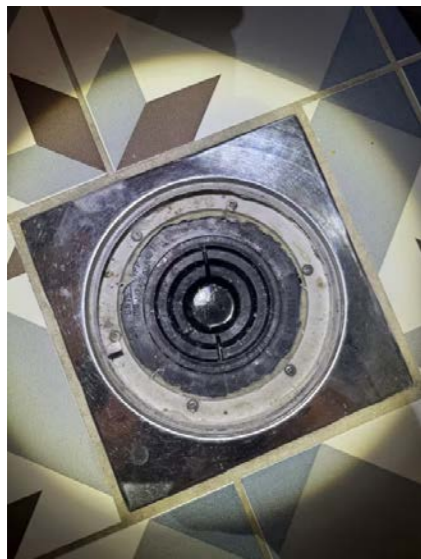
Sluk på toalettrom. Påstrykningsmembran ført til klemring i sluk, utførelse OK.
