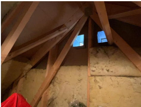
Adkomst til kaldtloft via luke med stige.
