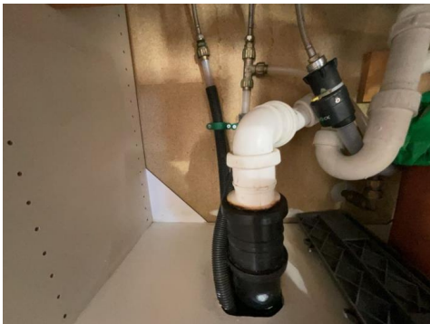
Synlige rør under kjøkkenbenken.
