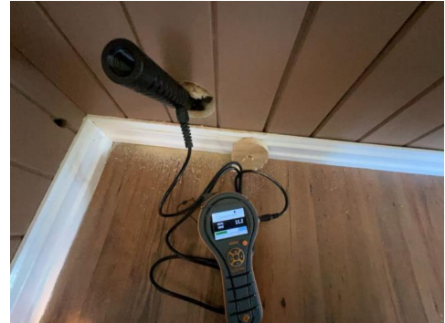
Ingen avvik registrert på befaringdagen.
