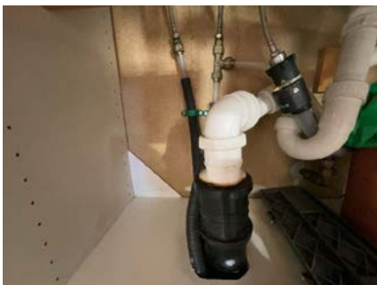
Synlige rør under kjøkkenbenken.
