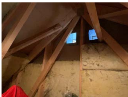
Adkomst til kaldtloft via luke med stige.
