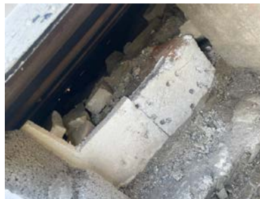
Begrenset tilgang for inspeksjon av krypkjeller.
