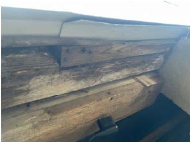
Bunnsvill det er utført fuktmåling i.
