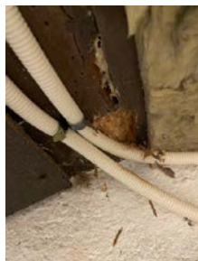
Bunnsvill det er utført fuktmåling i.
