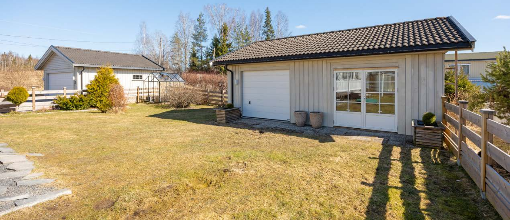
Uthus/garasje med innredede rom og adkomst fra hagen.
