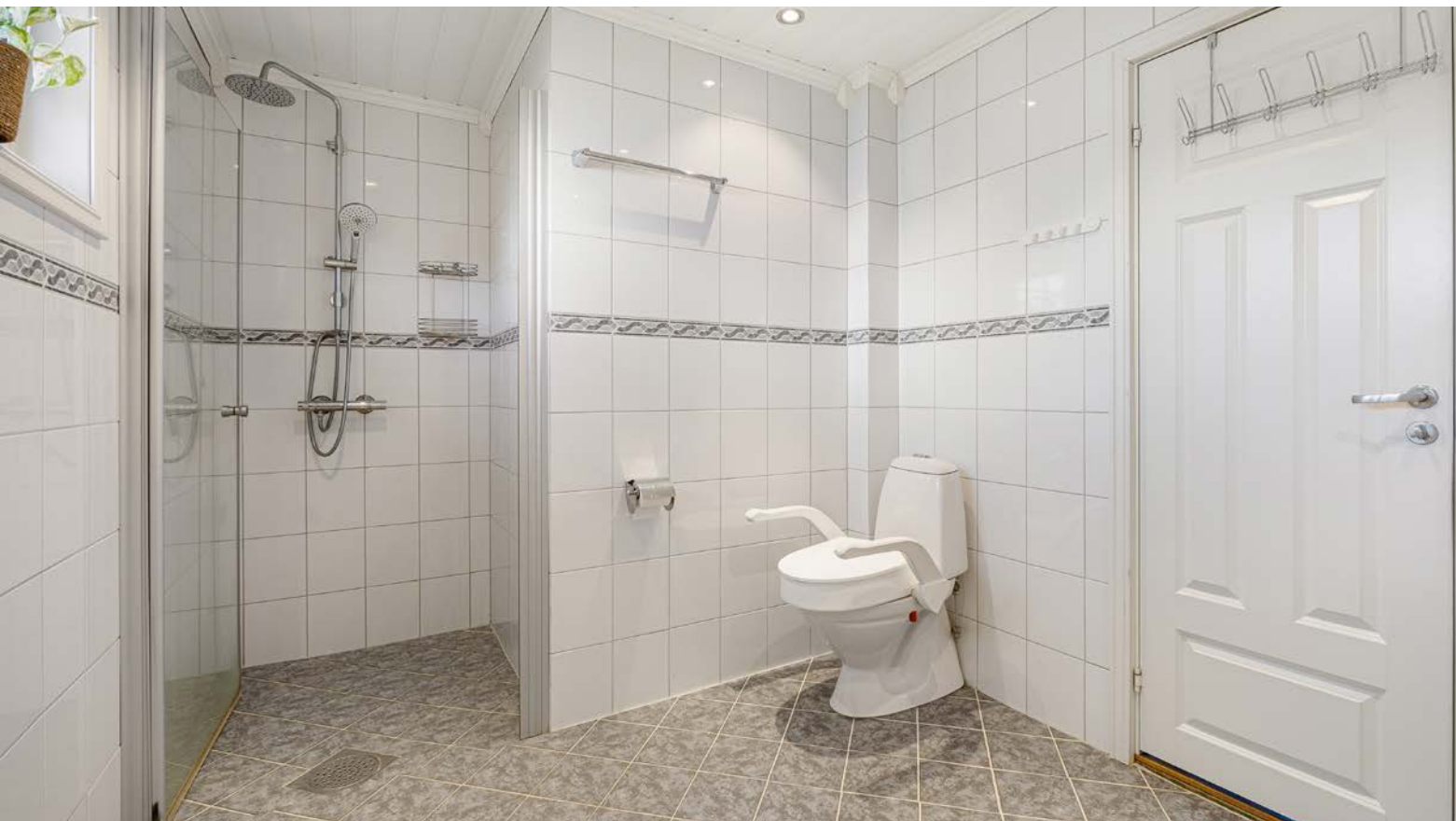
Badet er utstyrt med toalett og dusjhjørne med innfellbar glassdør.
