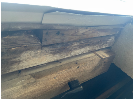
Bunnsvill det er utført fuktmåling i.
