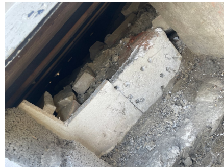
Begrenset tilgang for inspeksjon av krypkjeller.
