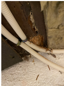
Bunnsvill det er utført fuktmåling i.
