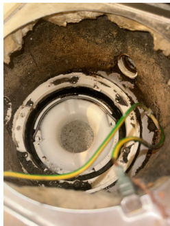
Plastsluk med klemring for membran
