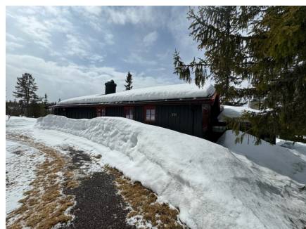
Nytt heldekkende pipebeslag på pipe fra stue/kjøkken
