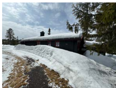
Nytt heldekkende pipebeslag på pipe fra stue/kjøkken
