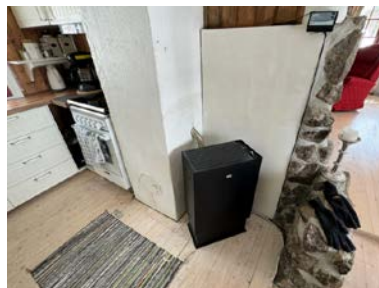
Pipe mot kjøkken har noe riss i murverk og krakelering på overflate.
